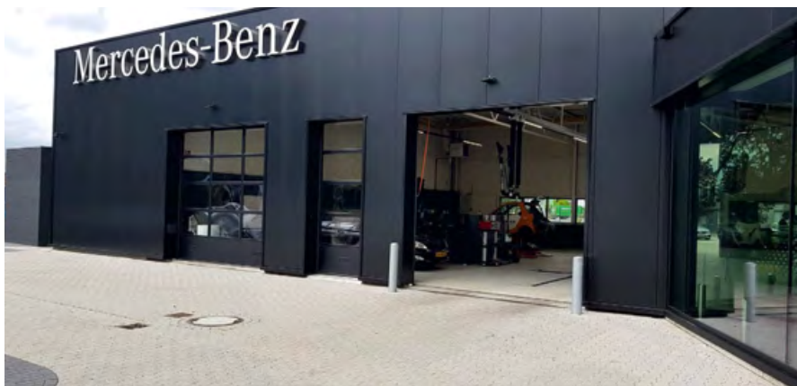
❖ Фото 1. Воздушное отопление автосервиса на газовых воздухонагревателях
