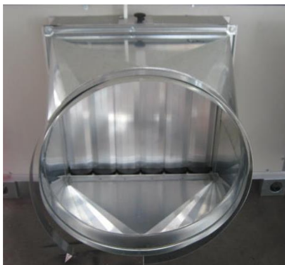
Воздушная заслонка рециркулируемого воздуха с ручной регулировкой
