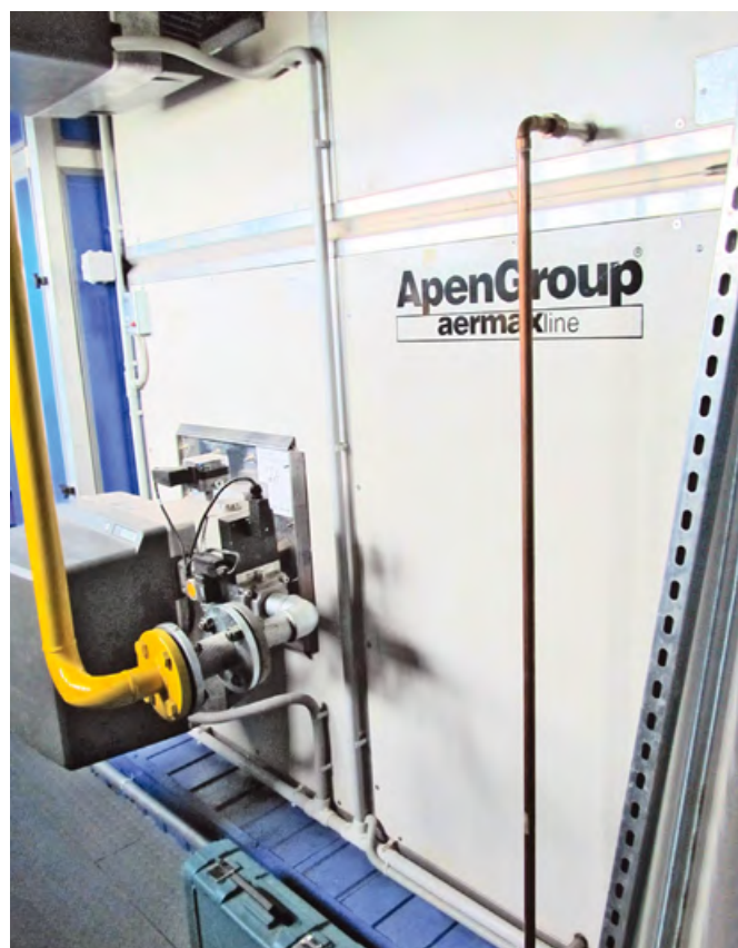
❖ Фото 5. Газовые секции нагрева со сливом конденсата
